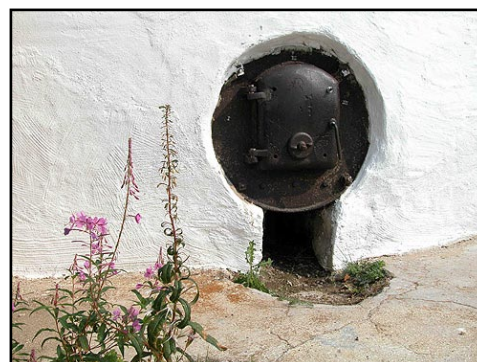
Illustr.11 Indfyriingslågen i bunden af den kubeformede kalkovn set udefra.
