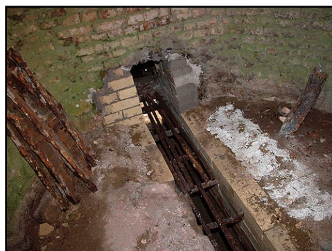
Illustr.10 Indfyriingskanalen i bunden af kalkovnen hvor kul blev tilført, og hvor igennem brændingen kunne kontrolleres
