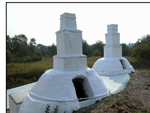
Illustr.8 Kalkovnene er bygget ind i skrænten for lettere at kunne fylde dem.
