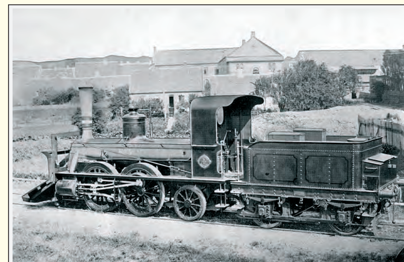
Damplokomotivet ØJJ-5 i 1877 ved Strømmen, første stop efter Randers. Østjyske Jernbane (ØJJ) indkøbte ialt 7 tyske Hanomag-lokomotiver til strækningen. Topfart: 50 km/t. Foto udlånt af www.jernbanen.dk
